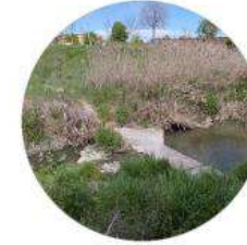
Travessa de formigó actual
