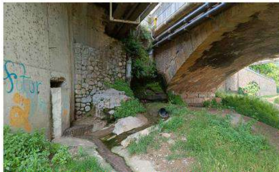
ESTAT ACTUAL DEL SOBREEIXIDOR 11 I LA SORTIDA DE BOMBAMENT DEL FREÀTIC
